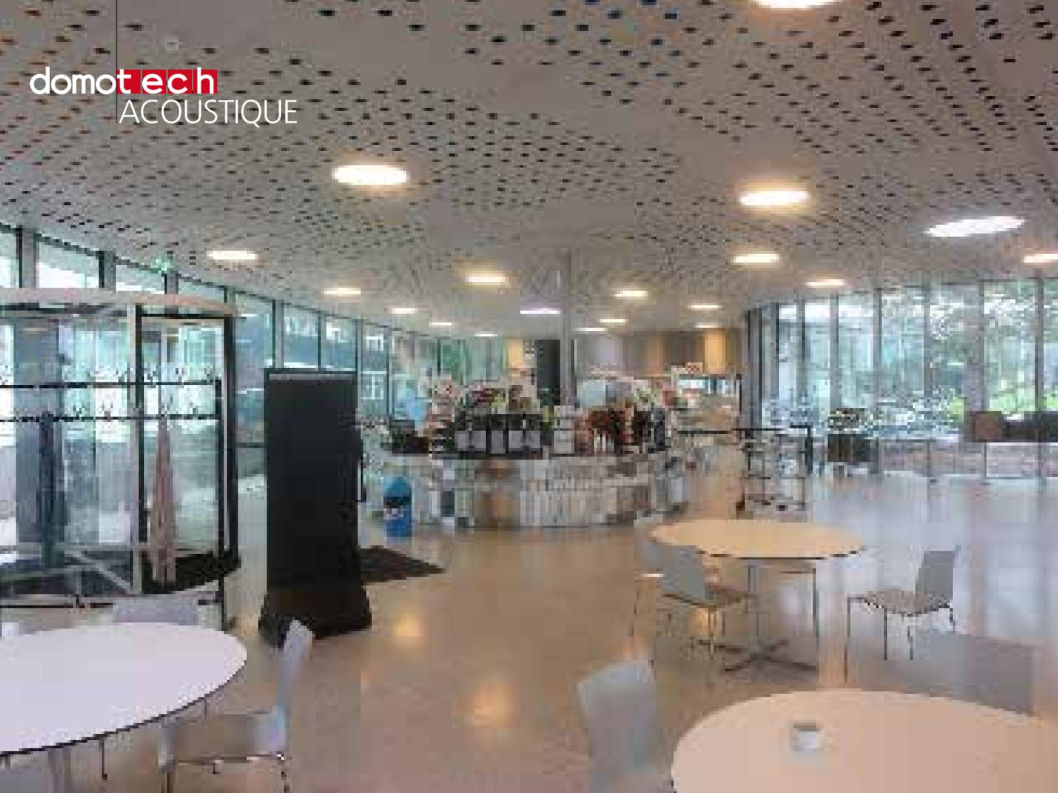
Le traitement acoustique est matérialisé par des «plots absorbants» intégrés dans la dalle béton du plafond, fixés contre le coffrage de dalle avant le coulage (profondeur 12 cm, diamètre 7 cm, entraxe 20 cm). De la laine minérale est placée au fond de chaque plot. Ce principe a été retenu par l'équipe de conception pour ses aspects esthétiques et innovants. Quelques rideaux épars le long de la façade sont également présents.
